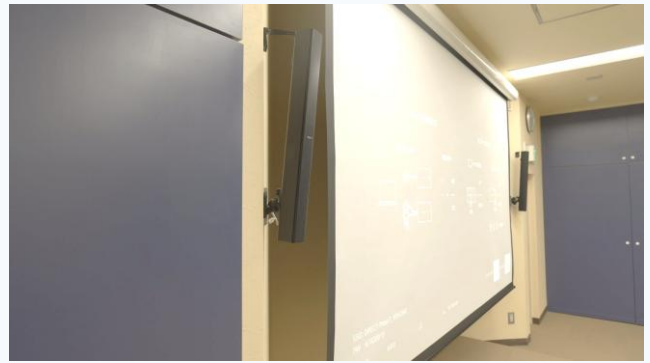
▲ ワイヤレス HDMI 投影+ラインアレイスピーカー
