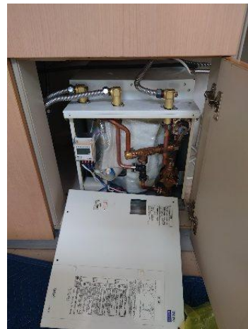
▲ エコキュート等の住宅設備工事も自社施工
